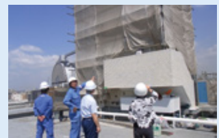
大規模修繕の進捗説明
